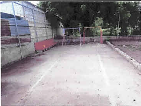
TORTA DE CEMENTO FINALIZADA
